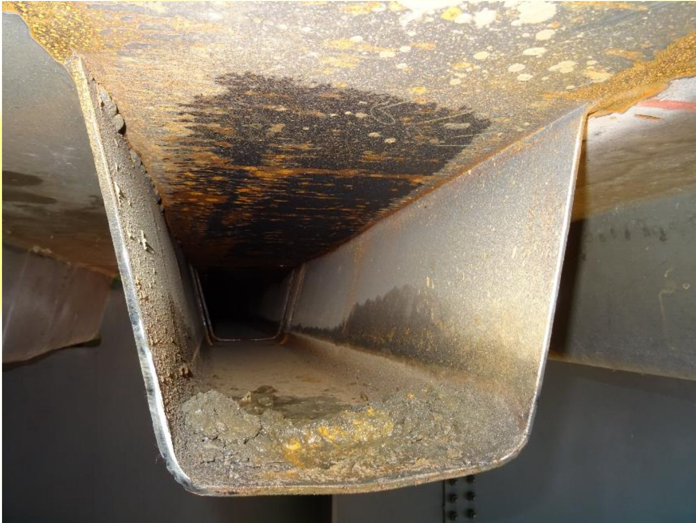
Autre vue de l'intérieur d'une nervure polluée
