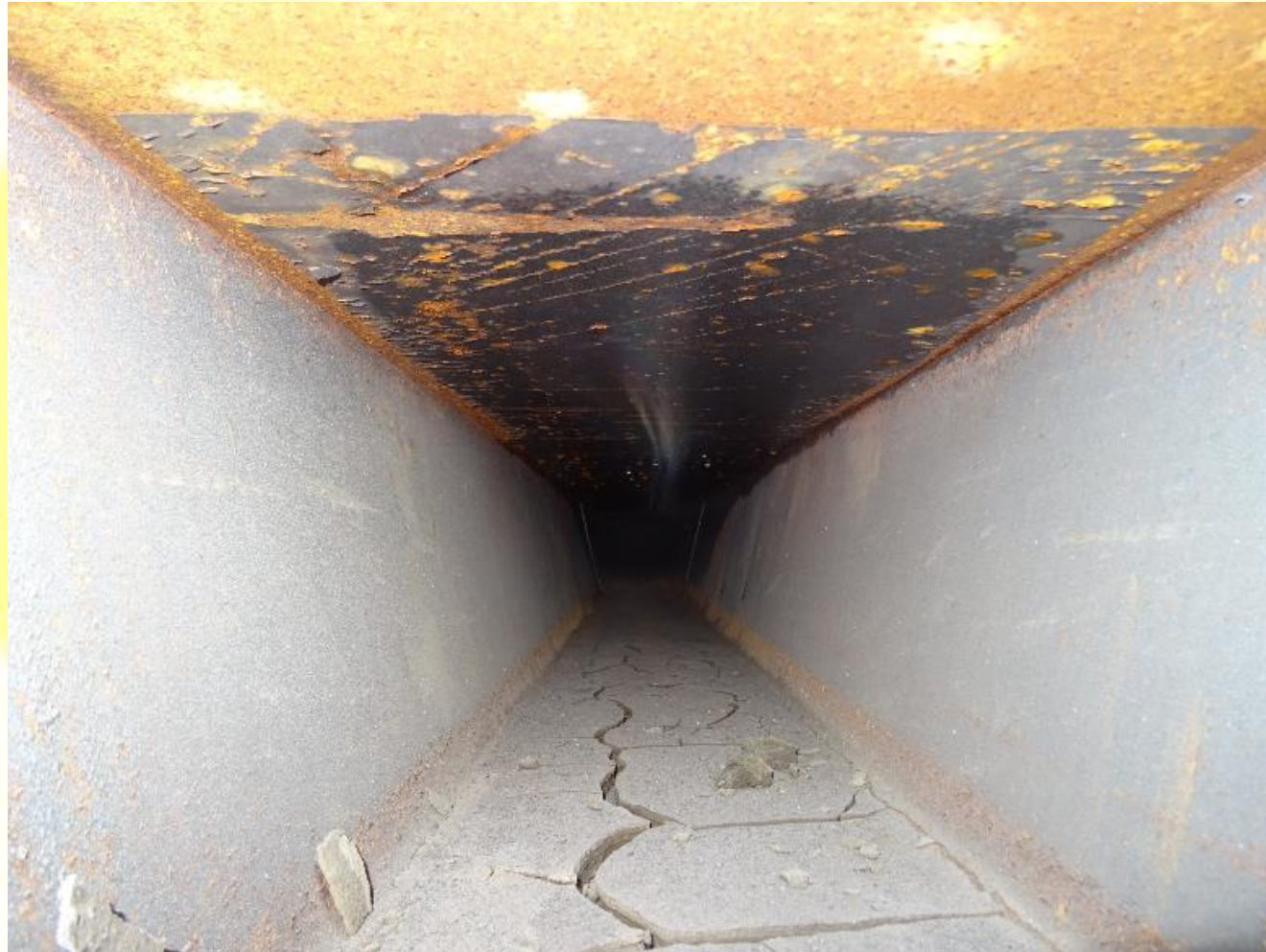
Exemple de nervure polluée
